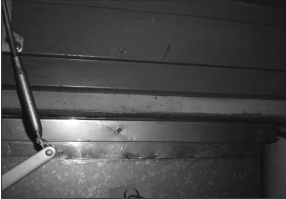
Metal Door Lintel Sample 57
